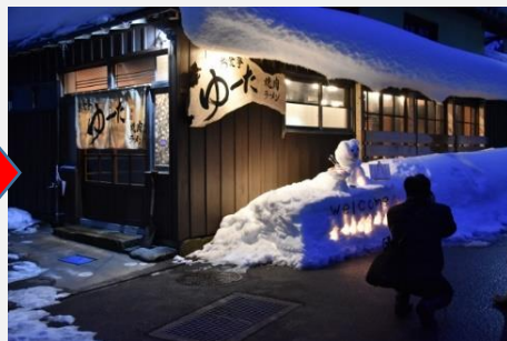
修理後(店舗として活用)
