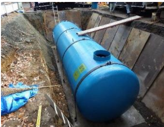
耐震性貯水槽の新設
