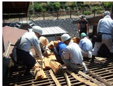
↓ ●住民による公開家屋石置き板屋根の屋根返し作業
