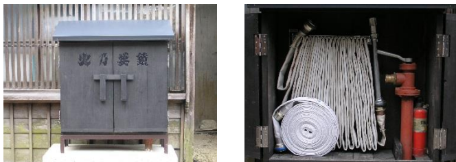
消火栓・ホース収納箱
