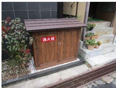
防災事業の例 (消火栓)
