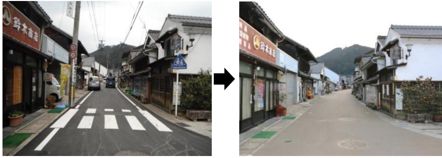
電線類地中化事業及び道路修景整備事業の例
