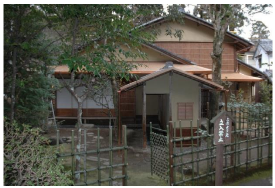
旧竹林院 茶室(広間) H17・18修理。 旧竹林院はもと里坊であつたものが、別荘として整備された。庭園は国名勝、2棟の茶室と四阿は市指定建造物。公開(有料)。
