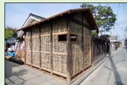
修理中の様子 (辻番所)
