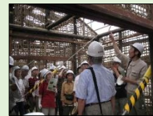
修理工事の公開 (旧池田屋敷長屋門)
