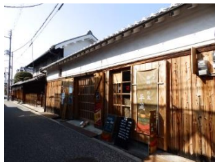
活用事例(蔵活用)
