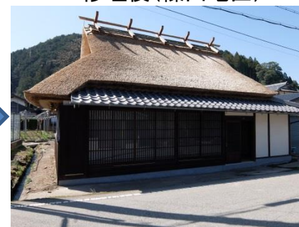
修理後(福住地区)
