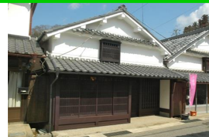
修理後(篠山地区)
