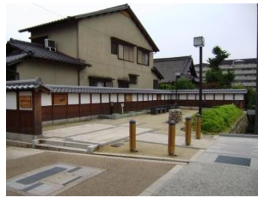
地区防災施設(防火水槽等を設置)
