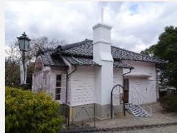
耐震補強: 旧ウォーカー住宅
