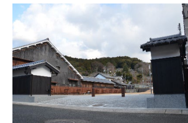
広場と防災倉庫
