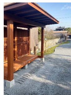
休憩所・東屋整備
