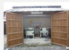
ポンプ格納庫
