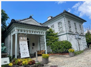
耐震補強: 自由亭
