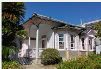
耐震補強: 旧ウォーカー住宅
