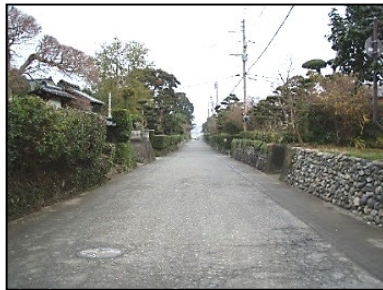
<無電柱化(裏配線)>
