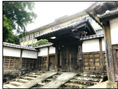
<出水御飯屋門修理工事>
