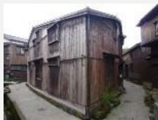
公開民家「三角家」 平成24年公開
