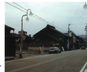
(店舗解体・更地)
