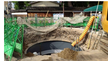
防火水槽工事中
