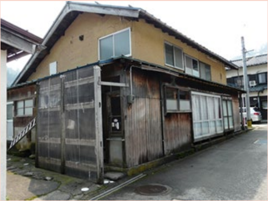
修理前(伝統的建造物)
