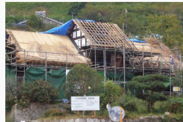
工事中の甲州民家情報館
