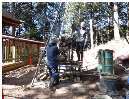
ボーリングによる地質調査
