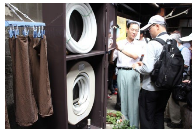
屋外易操作消火栓
