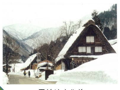
電線地中化後
