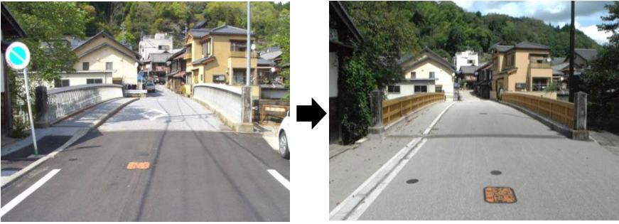
橋梁整備事業の例
