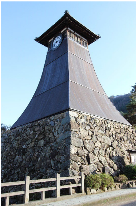
▲辰鼓楼(時計台)H29修理
