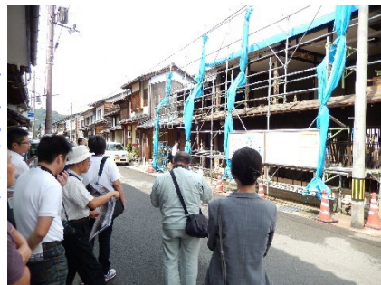
▶ 修理現場見学会
