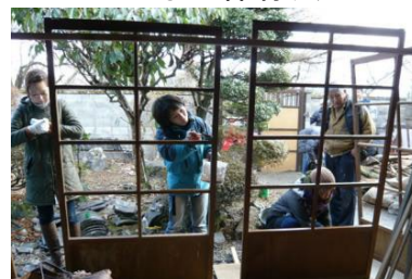
NPOによる古民家再生
