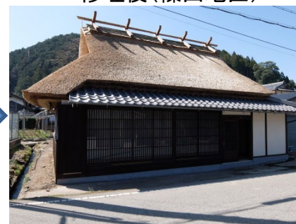
修理後(福住地区)
