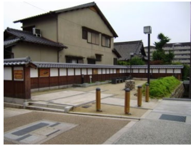
地区防災施設(防火水槽等を設置)
