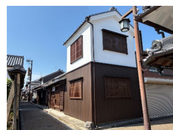
修理・修景後
