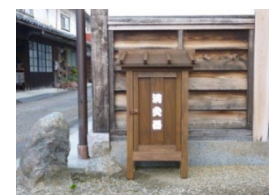
街かど消火器(防災事業)
