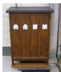
消火栓機材格納箱 (防災事業)
