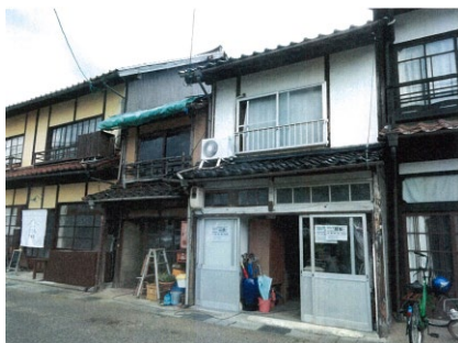
災害復旧事業・修理事業
