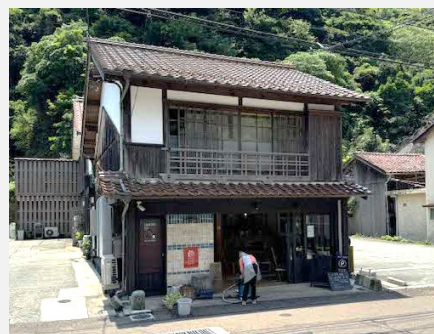
空家を活用した宿泊施設 シェアキッチン
