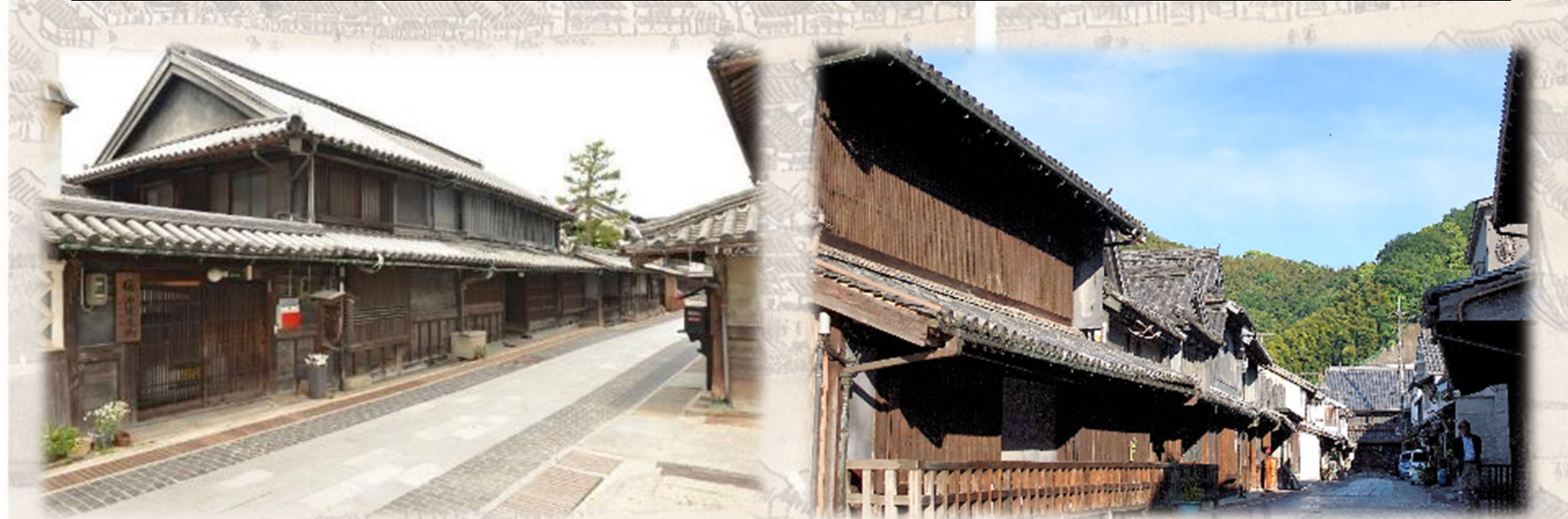
元禄4年（1691）建築の旧吉井家住宅
