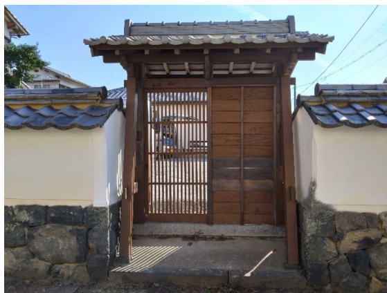
旧O家門修理
