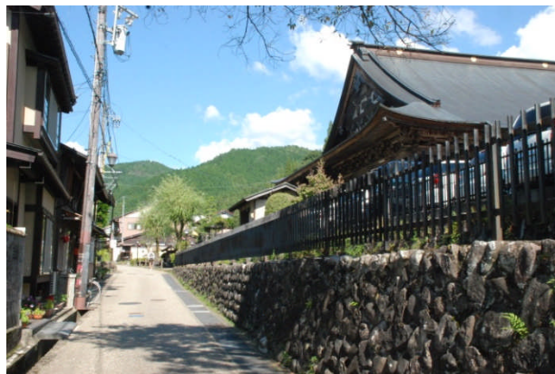
柳町の町並み（旧武家地）
