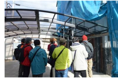
修理現場見学会
