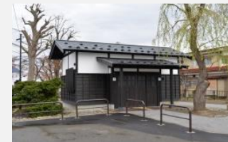
公衆トイレ 平成29年度整備
