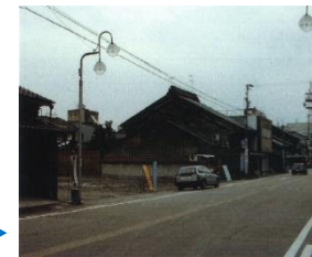
(店舗解体・更地)
