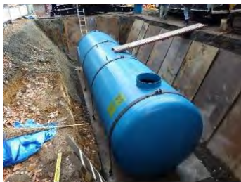
耐震性貯水槽の新設
