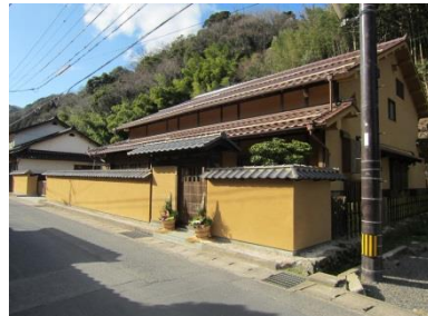
宿泊施設(新築修景)
