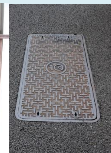
無電柱化事業 NTTケーブル 地下埋設
