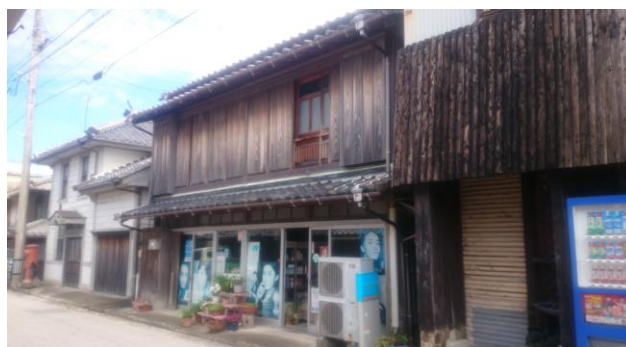
平成30年度 修理 (修理前)
