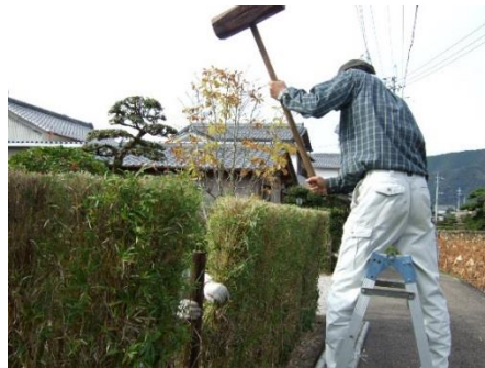
押縁を支えるための 杭を打ち込む作業
