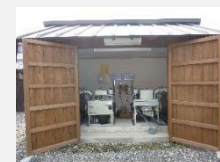
ポンプ格納庫
