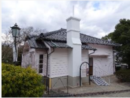
耐震補強: 旧ウォーカー住宅
