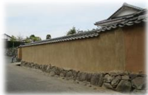
土塀修理完成
