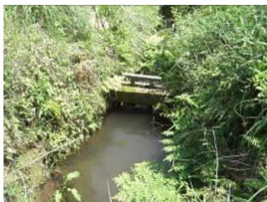
素掘りの 12 号水路と分水吐
