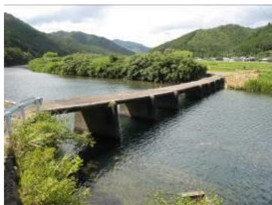
壺斗俵の沈下橋
