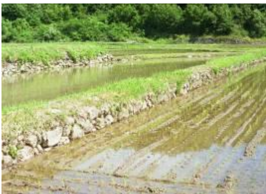
扇状地礫による畦の擁壁
