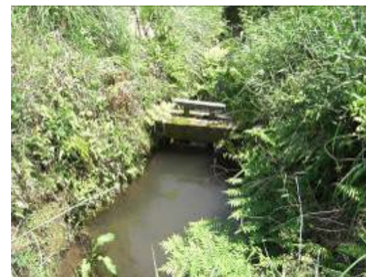
素掘りの12号水路と分水吐
