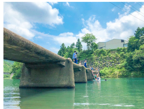
壺斗俵の沈下橋
