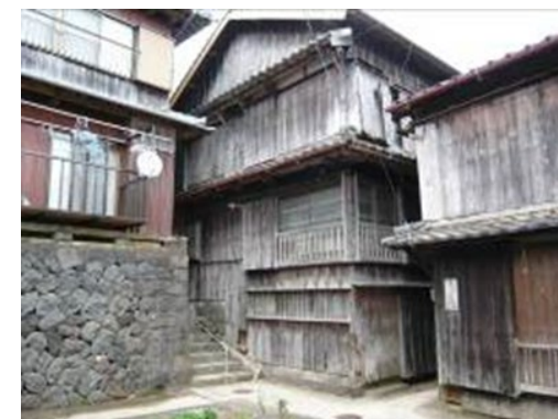
浦町地区の古民家と石垣
