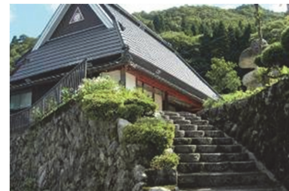
石臼の未完成品を用いた階段
