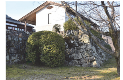
錦帯橋への水流を弱める石出し護岸
