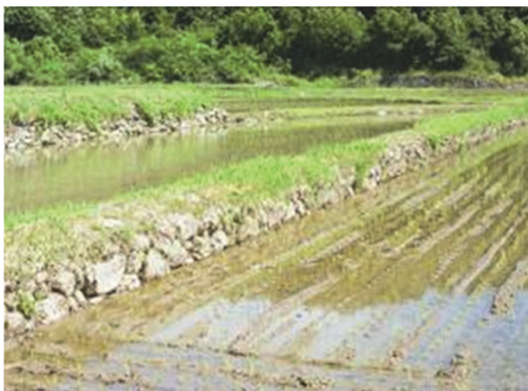
扇状地礫による畦の擁壁
