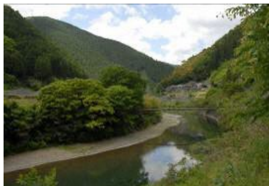
梼原川に架かる初瀬橋
