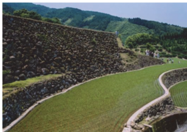
高さ8.5mの高石垣（南川原）
