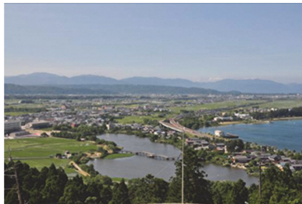
大溝遠景 (右が琵琶湖、中央が乙女ヶ池)
