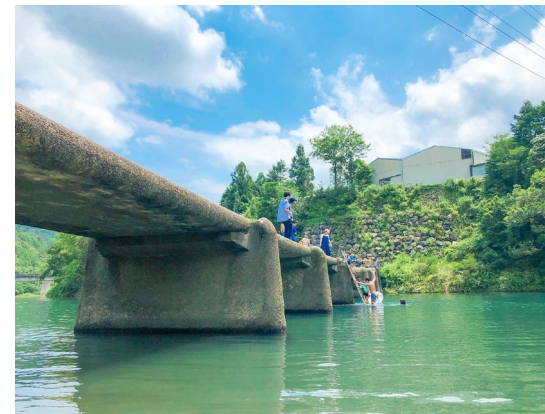
壺斗俵の沈下橋
