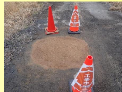
(埋戻し修繕後)
