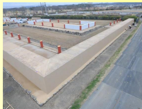
(修繕後※完成検査前)
