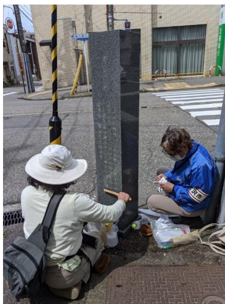
写真5 まちしるべ補修の様子
